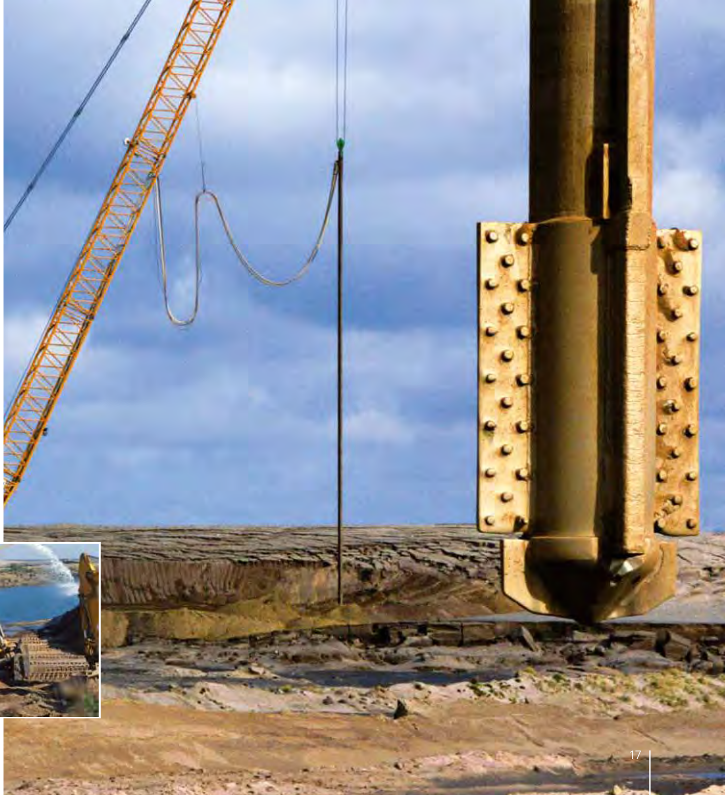
Rütteldruckverdichtung im Innenkippen- bereich Schlabendorf-Süd, 2008
