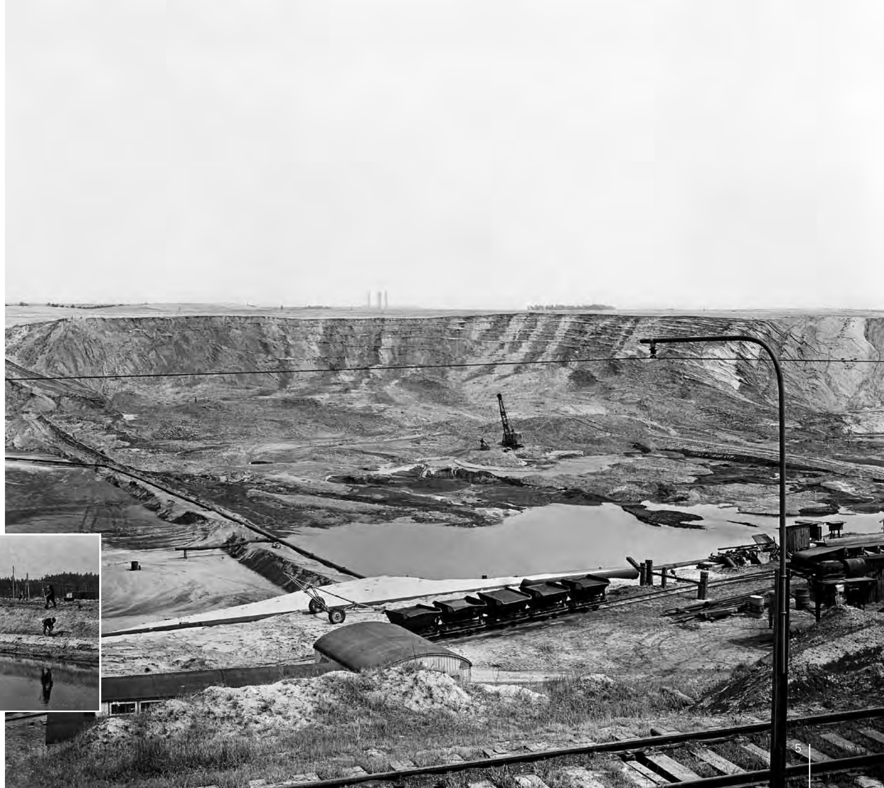
Rutschung im Tagebau Schlabendorf-Nord (Restloch A), 16. Mai 1966
