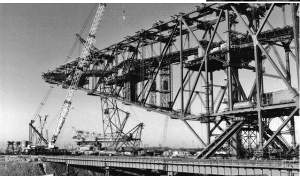
Aufbau der Abraumförderbrücke F60 im Tagebau Klettwitz-Nord, 1990
