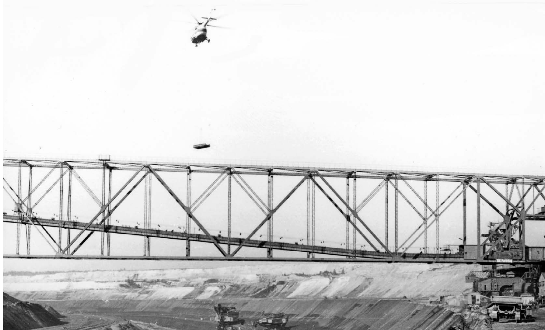
Umbau der Bandanlage auf der Förderbrücke „Klettwitz“ mit Hubschraubereinsatz zum Materialtransport, 1971
