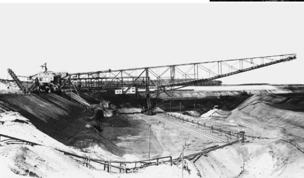
Abraumförderbrücke Koyne im gleichnamigen Tagebau, 1934
