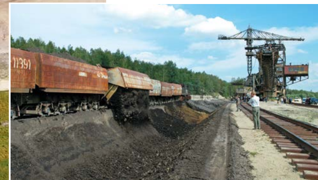
Kippen des letzten Abraumzuges am Absetzer 1061 im Tagebau Klettwitz, 2004 Naturschutzgebiet Grünhaus im Bereich des ehemaligen Tagebaus Kleinleipisch, 1997
