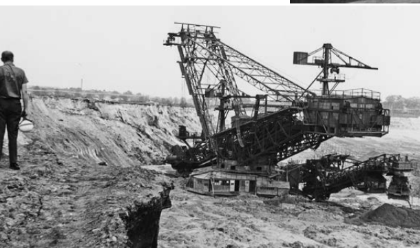
Von Altkippenrutschung eingeschlossener Bagger SRs 1200-131, 1970
