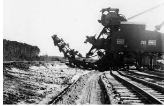
Aufschlussbaggerung im Tagebau Kleinleipisch, 1910
