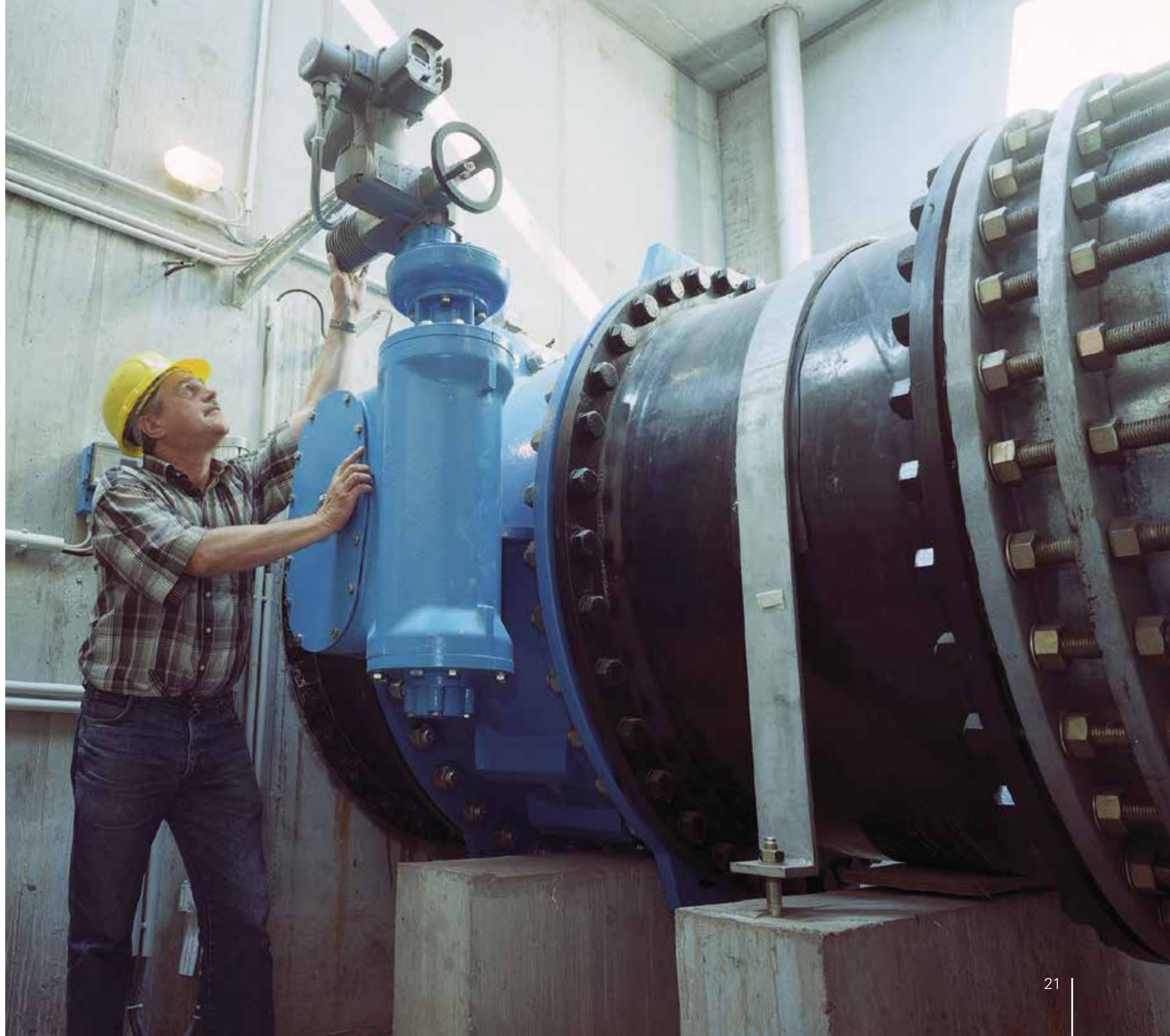
Kontrolle einer Messeinrichtung an der Flutungsleitung der Neißewasserüberleitung, 2005
