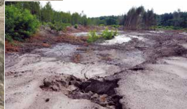
Bereich des Grundbruches auf der Innen- kippe im Raum Spreetal/Bluno, 2016 Sanierungsarbeiten im Tagebau Spreetal, 1992 Schließung des ehemaligen Drehpunktes im Restloch Spreetal, 1994
