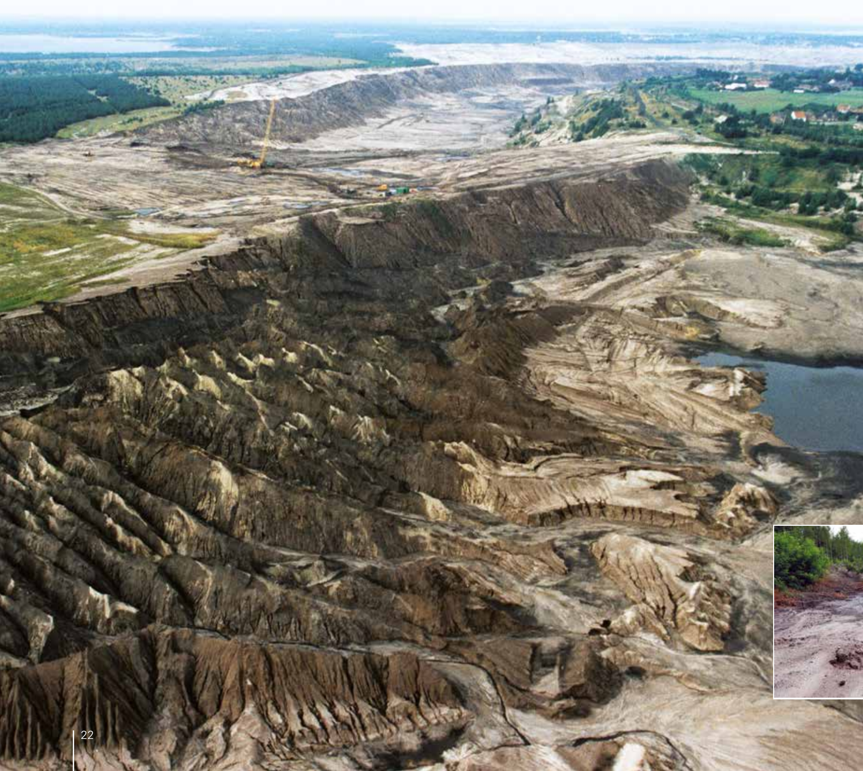
Sanierungsarbeiten im Tagebau Spreetal im Bereich des Blunodammes, 1996
