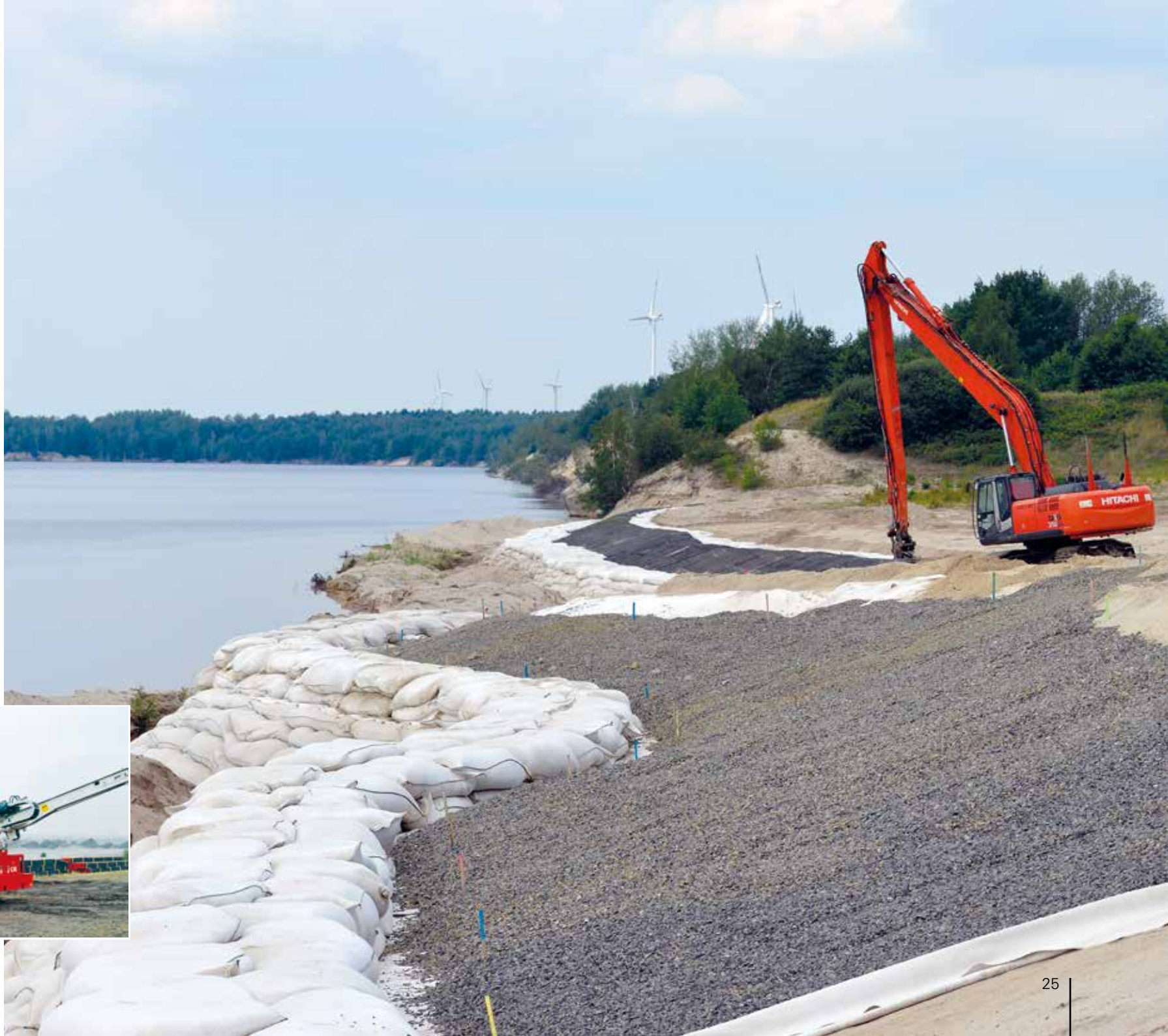
Kliffsicherung am Nordufer des Restloches Bluno, 2016
