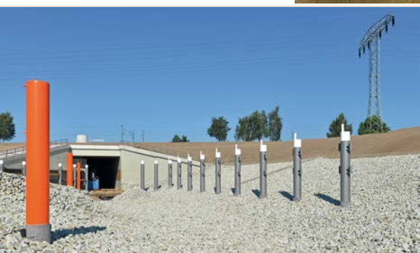
Blick auf des Tunnelbauwerk des Überleiters 11, 2014
