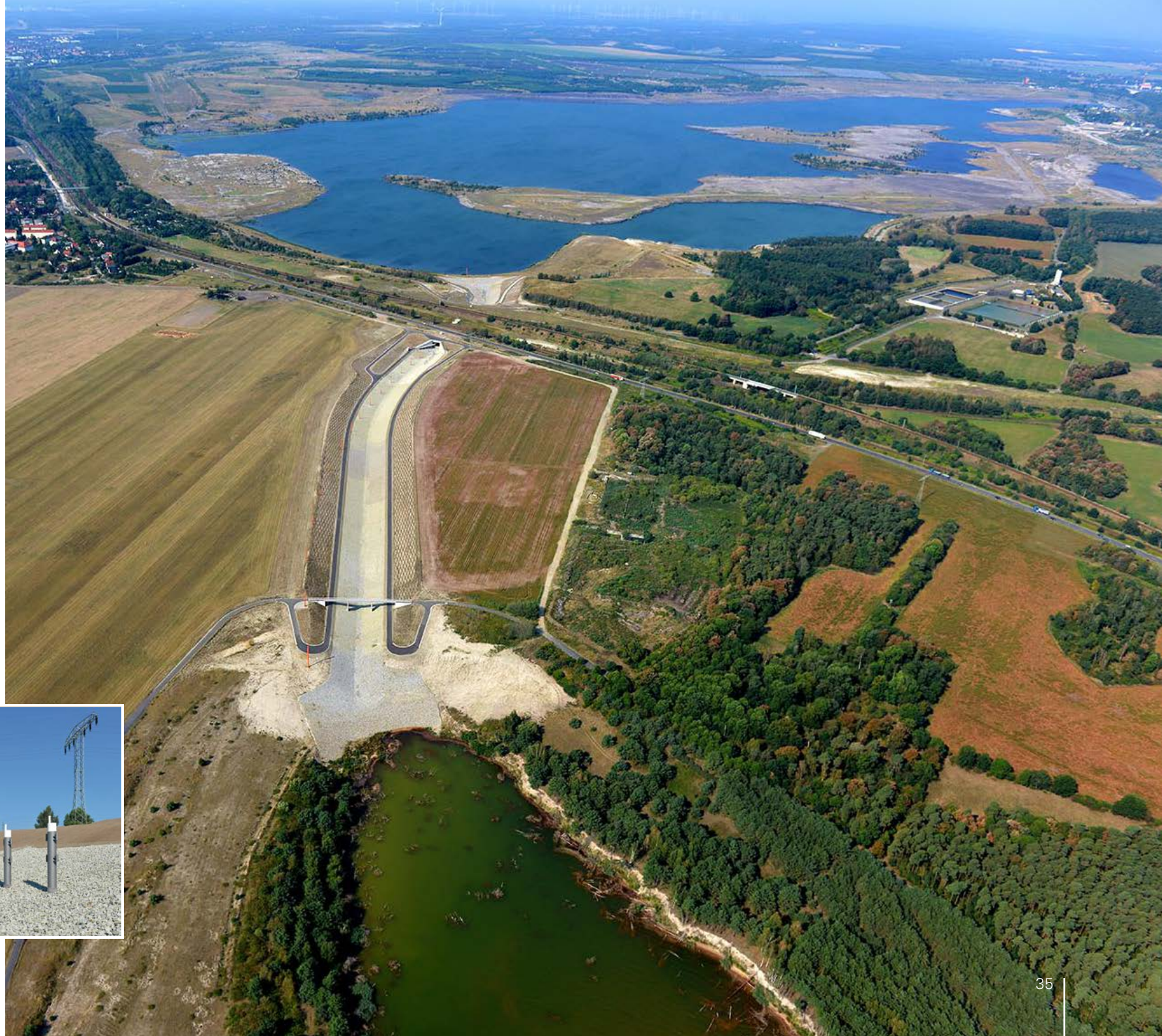
Ilse Kanal (Überleiter 11) zwischen Großräscher See (hinten) und Sedlitzer See (vorn), 2015
