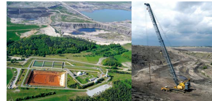
Grubenwasserreinigungsanlage Raintiza, 2008 Rütteldruckverdichtung im Tagebau Meuro, 2005 „Wasser marsch!“ im Tagebau Meuro, 2007
