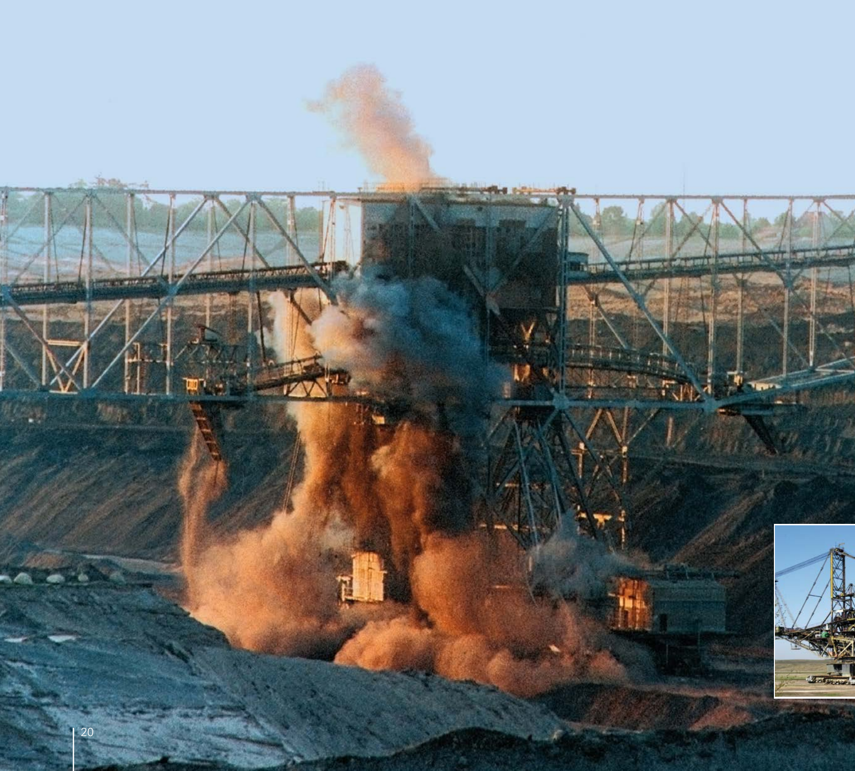
Sprengung der Abraumförderbrücke F 45 im Tagebau Meuro, 2000
