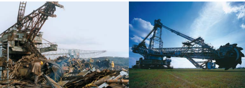
Sprengung des Absetzers A 2 RsB 12.500-1096, 2004 Demontage eines Eimerkettenbaggers, 2000 Schaufelradbagger SRs 1500 als Industriedenkmal am EuroSpeedway Lausitz, 2003
