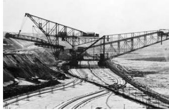
Abraumförderbrücke 13 Meurostolln im gleichnamigen Tagebau, 1942; 1945 als Reparationsleistung in die UdSSR transportiert
