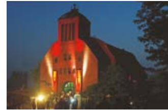
Event in der ehemaligen Kraftzentrale im Industriepark Marga, 2003
