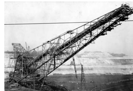
Errichtung der Abraumförderbrücke „Meurostolln“ im Tagebau VI Stadtfeld, 1941
