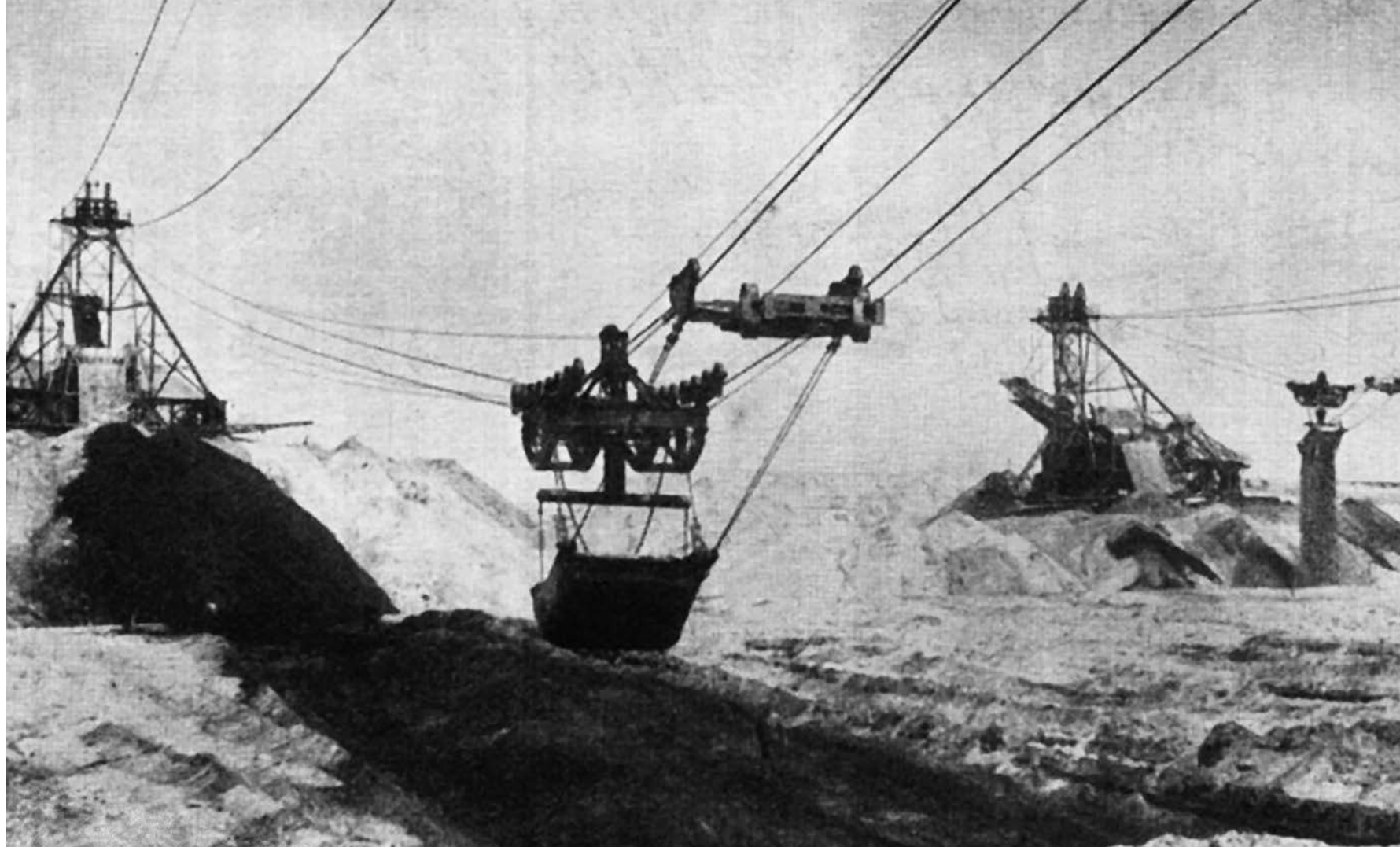
Laufkatze eines Bleichertschen Kabelbaggers in der Grube Victoria III, 1930
