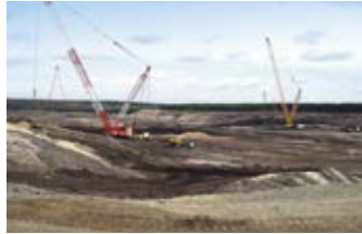
Rütteldruckverdichtung auf der neuen Deponiefläche bei Hörlitz, 2005
