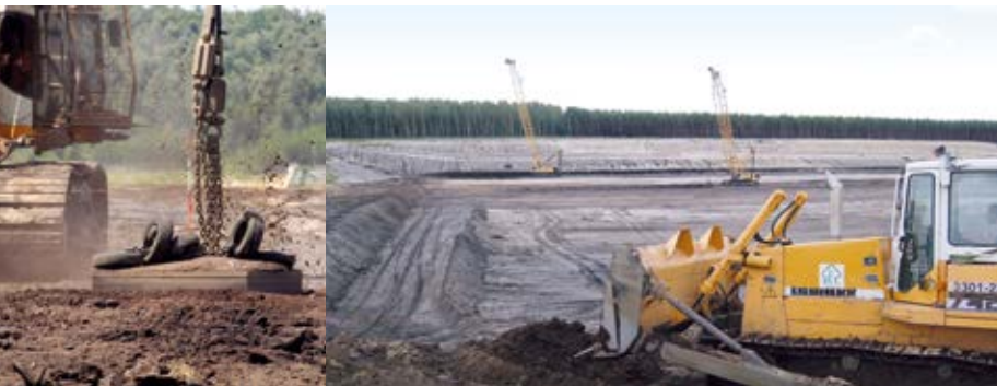
Rütteldruckverdichtung am Kabelbaggerteich, 2015
