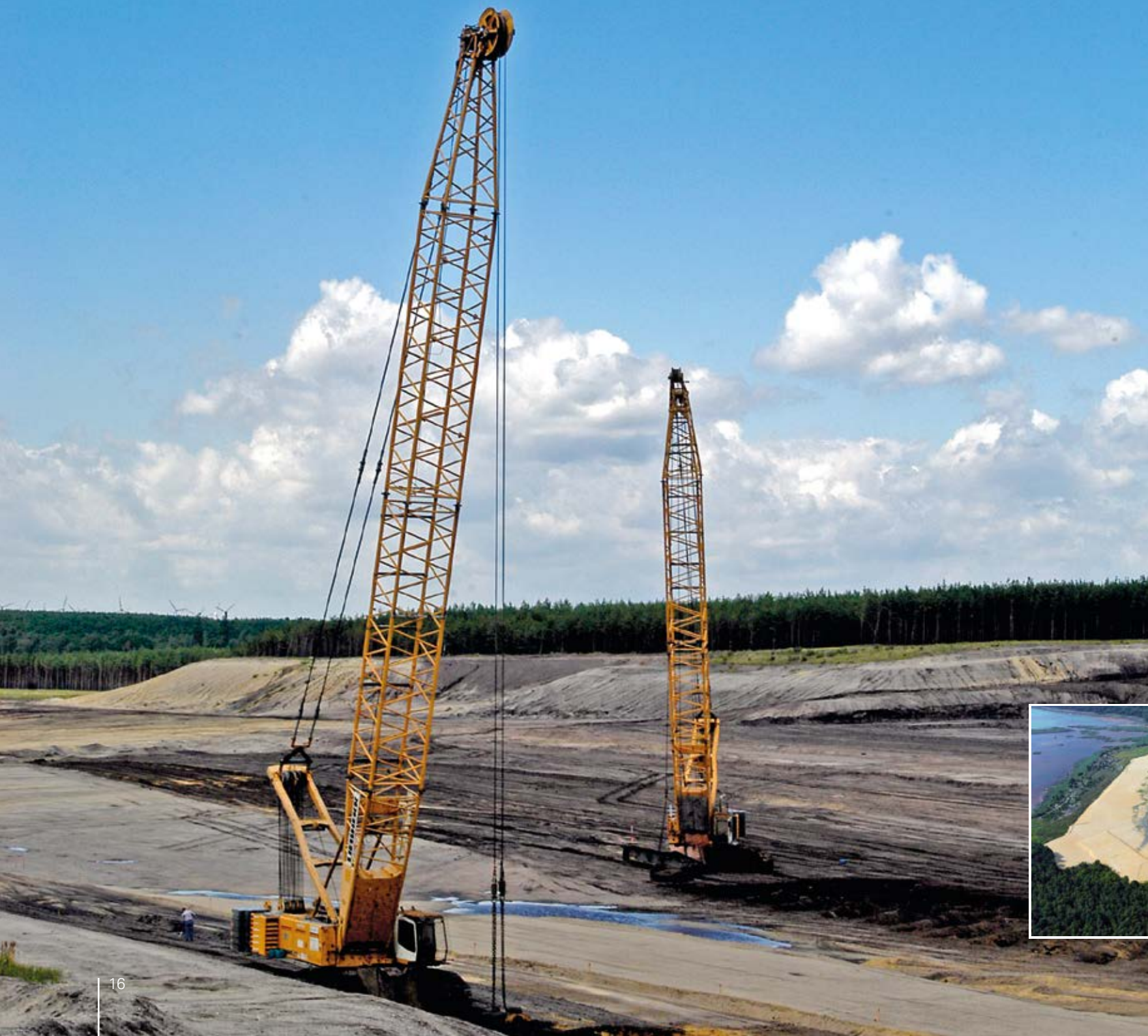
Bodenverdichtungsmaßnahmen im Sanierungsgebiet Meuro-Süd, 2007
