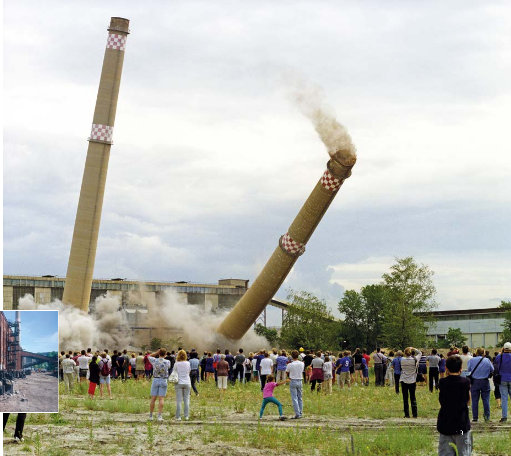
Sprengung der Schornsteine der Brikettfabrik Brieske, 2000
