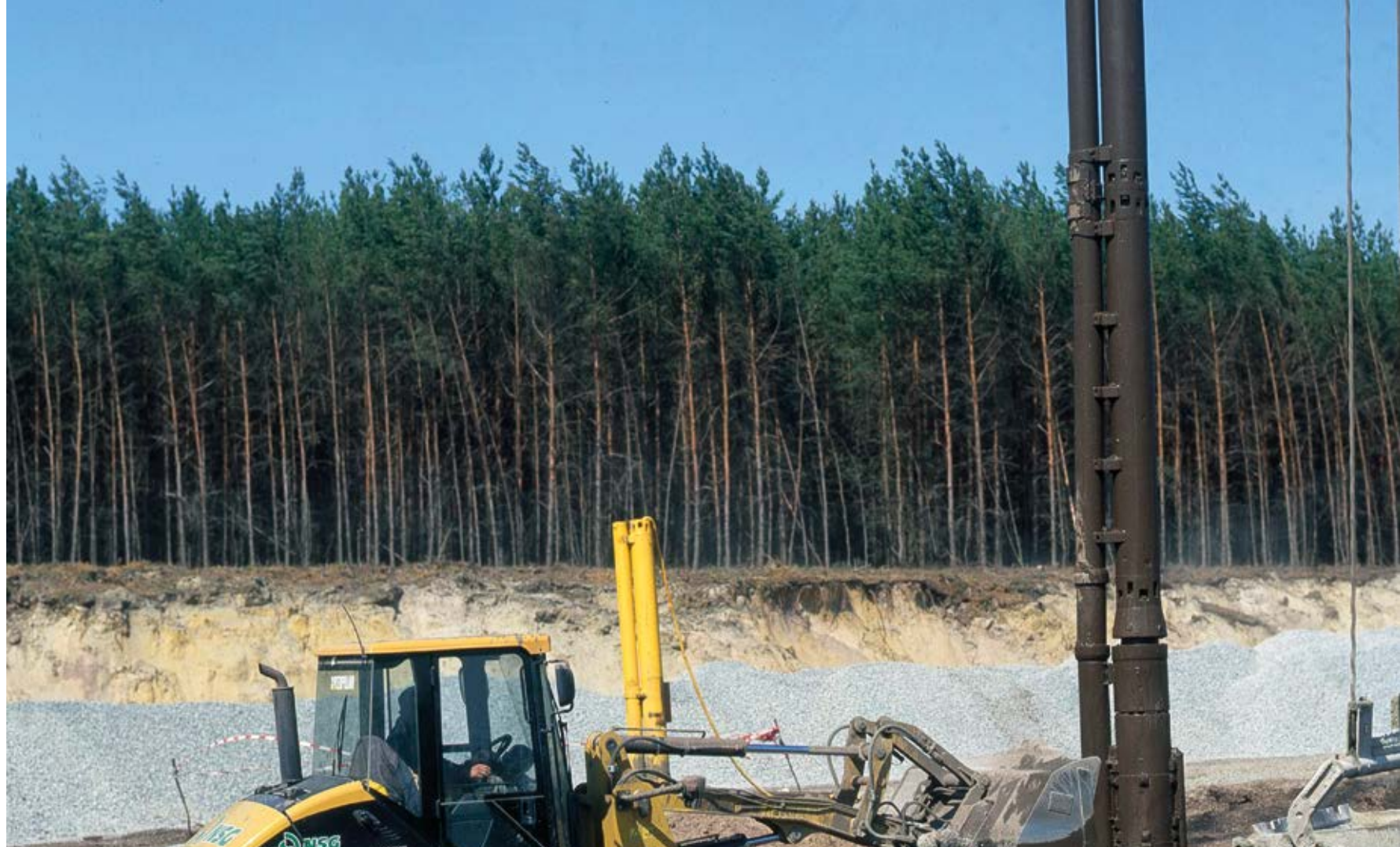
Verdichtungsarbeiten auf der Trasse der Ortsumgehung Senftenberg der B169n, 2008
