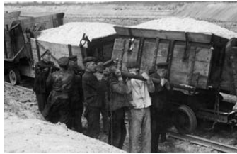
Manuelles Kippen von Abraum im Tagebau Clara I, 1927
