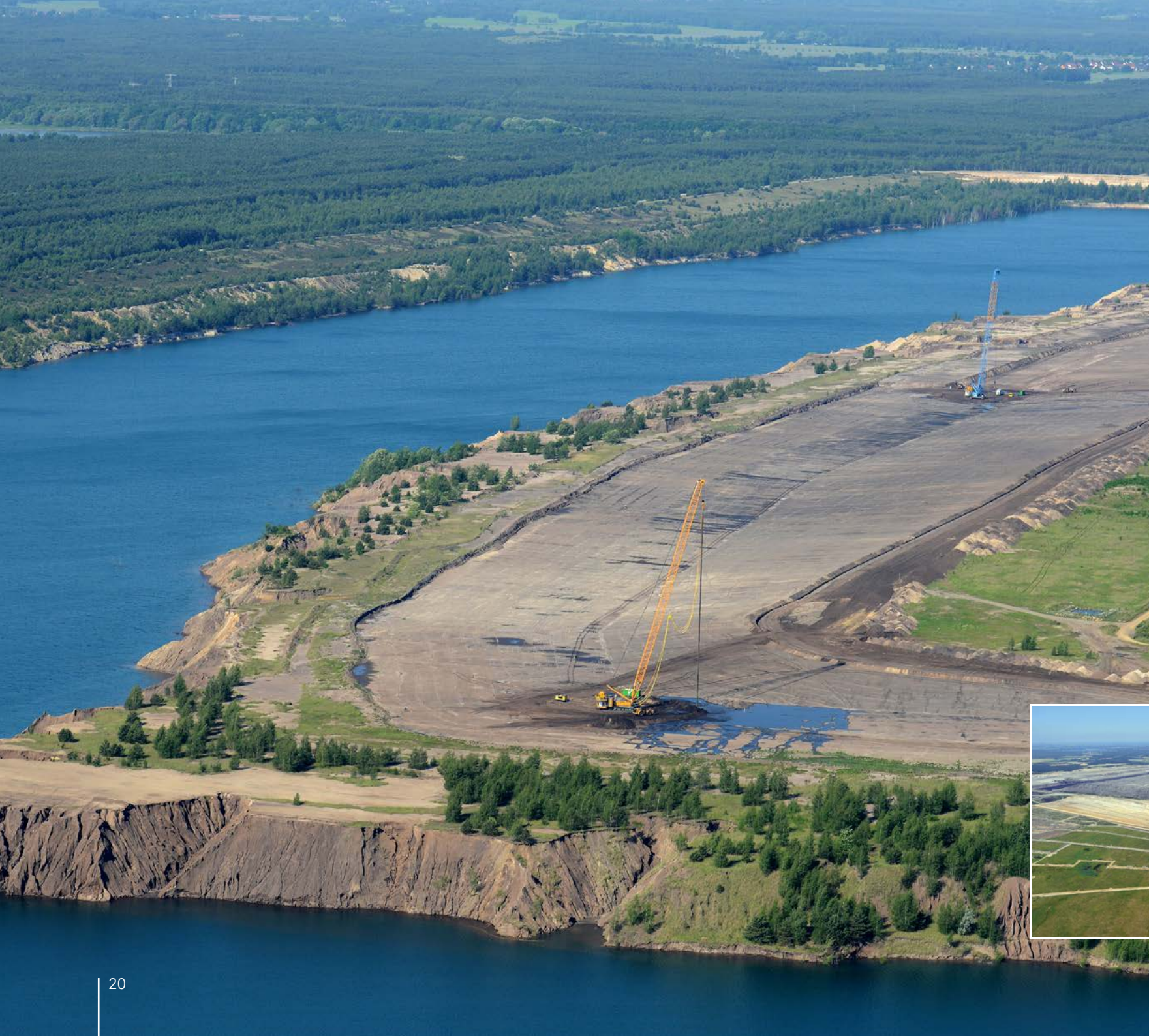
Rütteldruckverdichtung am Ufer des entstehenden Klinger Sees, 2014
