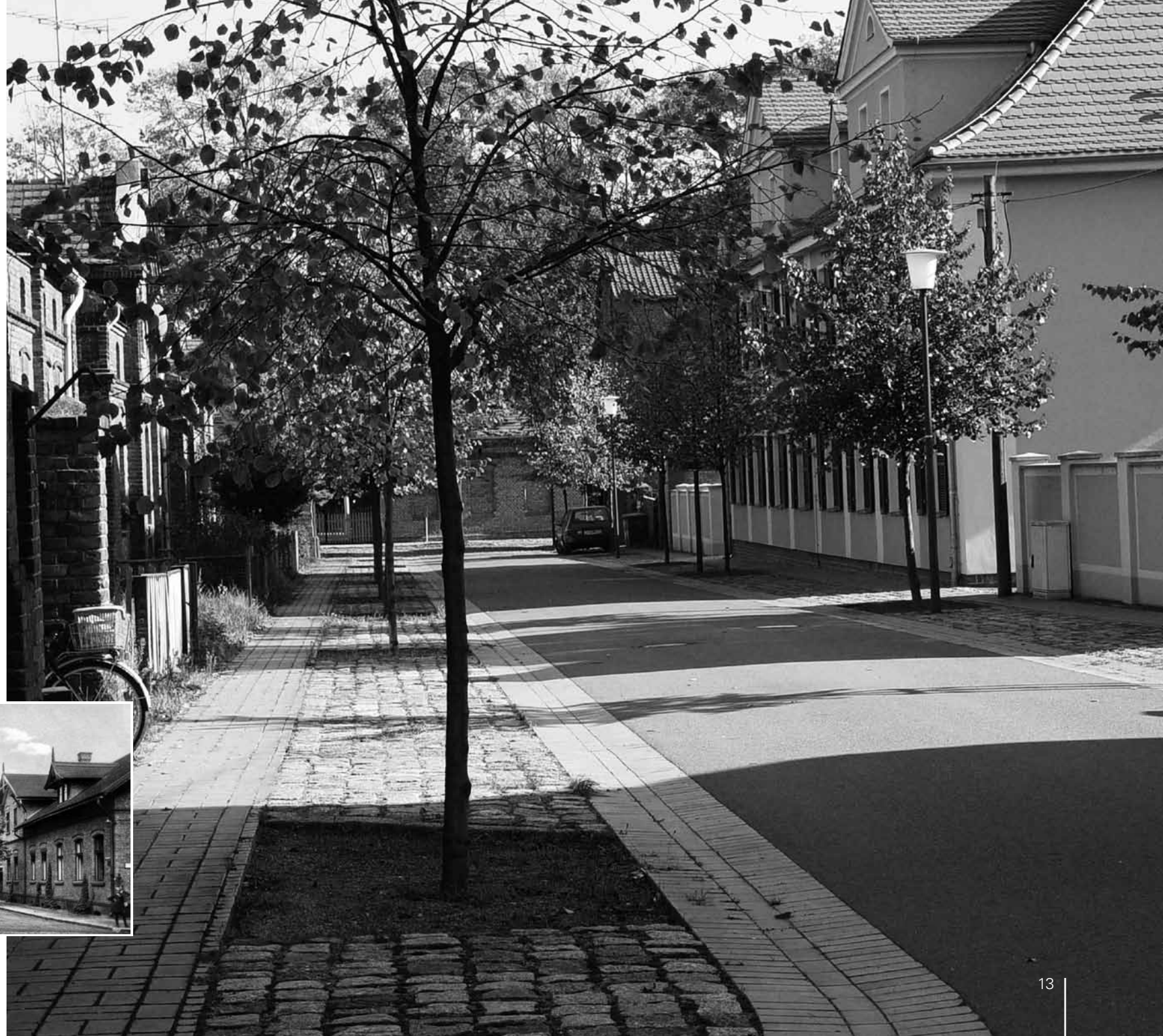
Sanierte Glasarbeitersiedlung Annahütte, 2004
