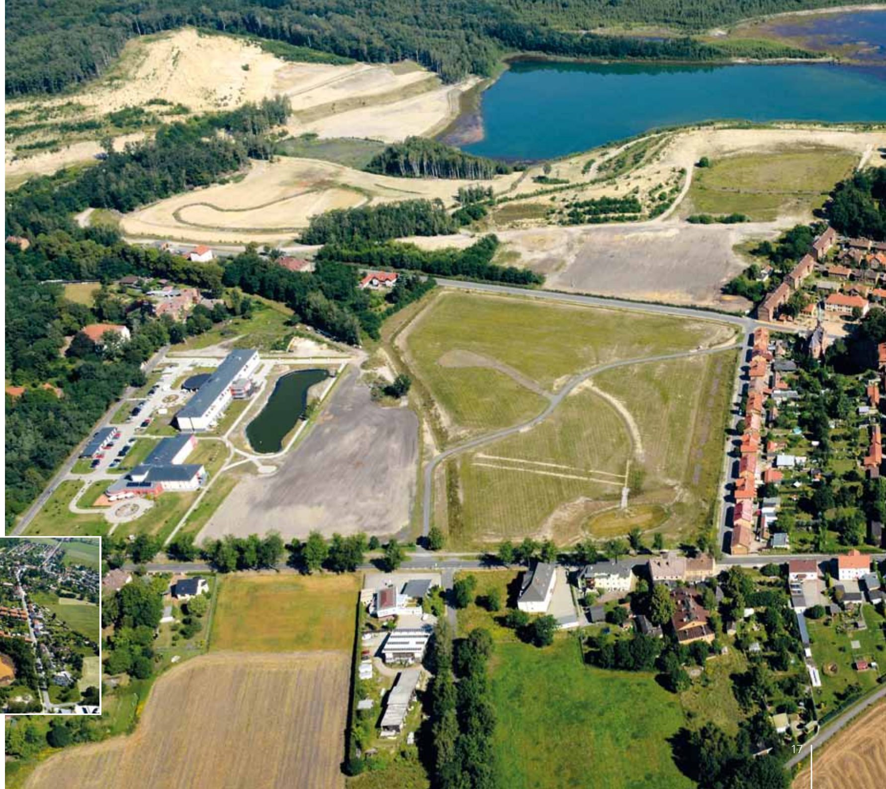
Restloch 4 nach vollendeter Sanierung (Bildmitte), 2012
