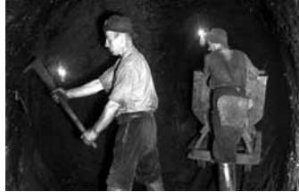
Arbeiten in einer untertägigen Entwässerungsstrecke, um 1920
