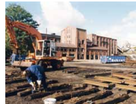
Abbruch der Brikettfabrik und des Kraftwerks Heide, 1994/95 Rahmenplan Heide, 2012 (Hinweis: Die Nummerierung der Restlöcher korrespondiert nicht mit den Nummern der Tagebaue.)
