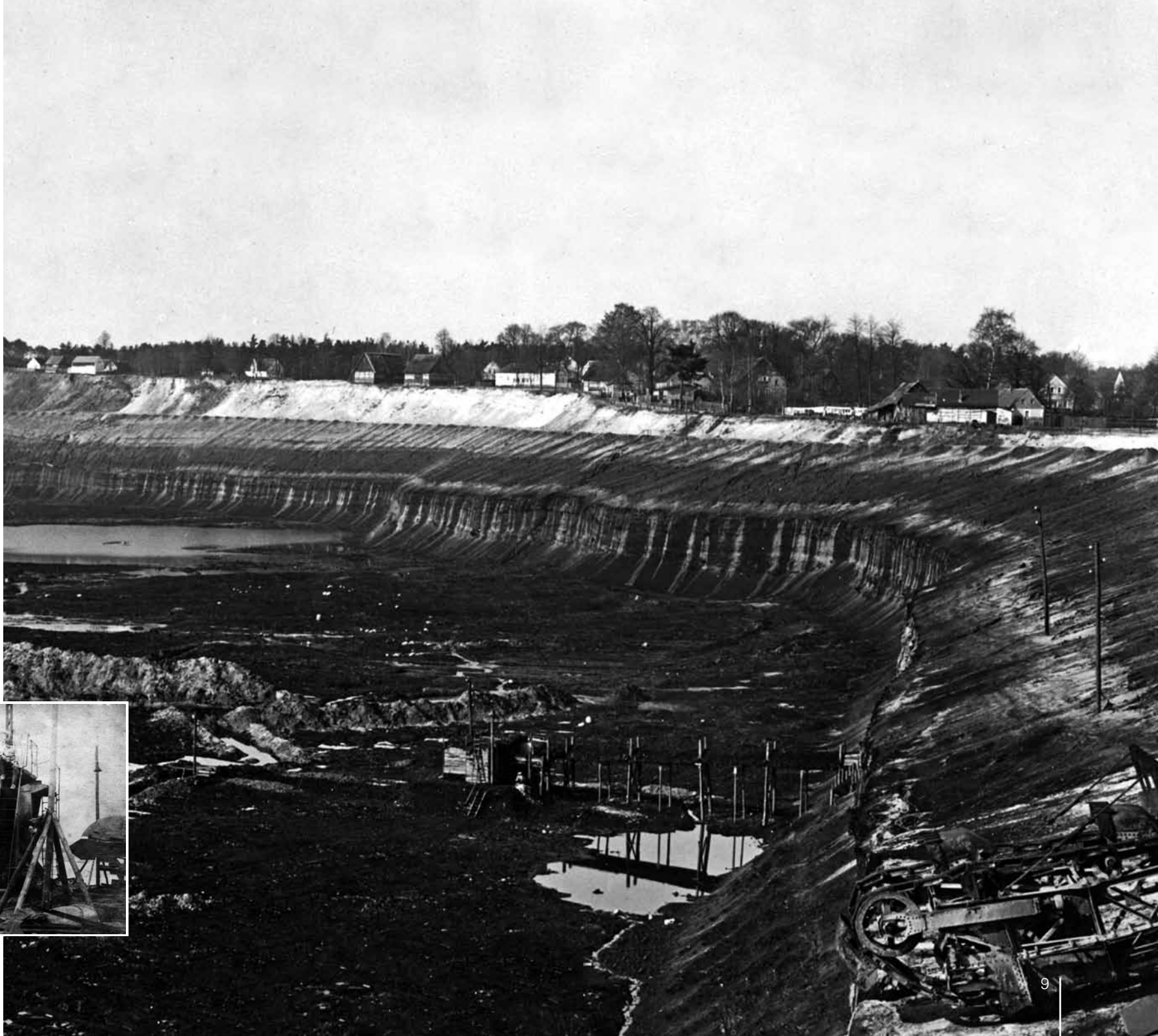
Tagebau der Grube Clara III bei Zeiðholz am Tag der Stilllegung, 12. April 1934
