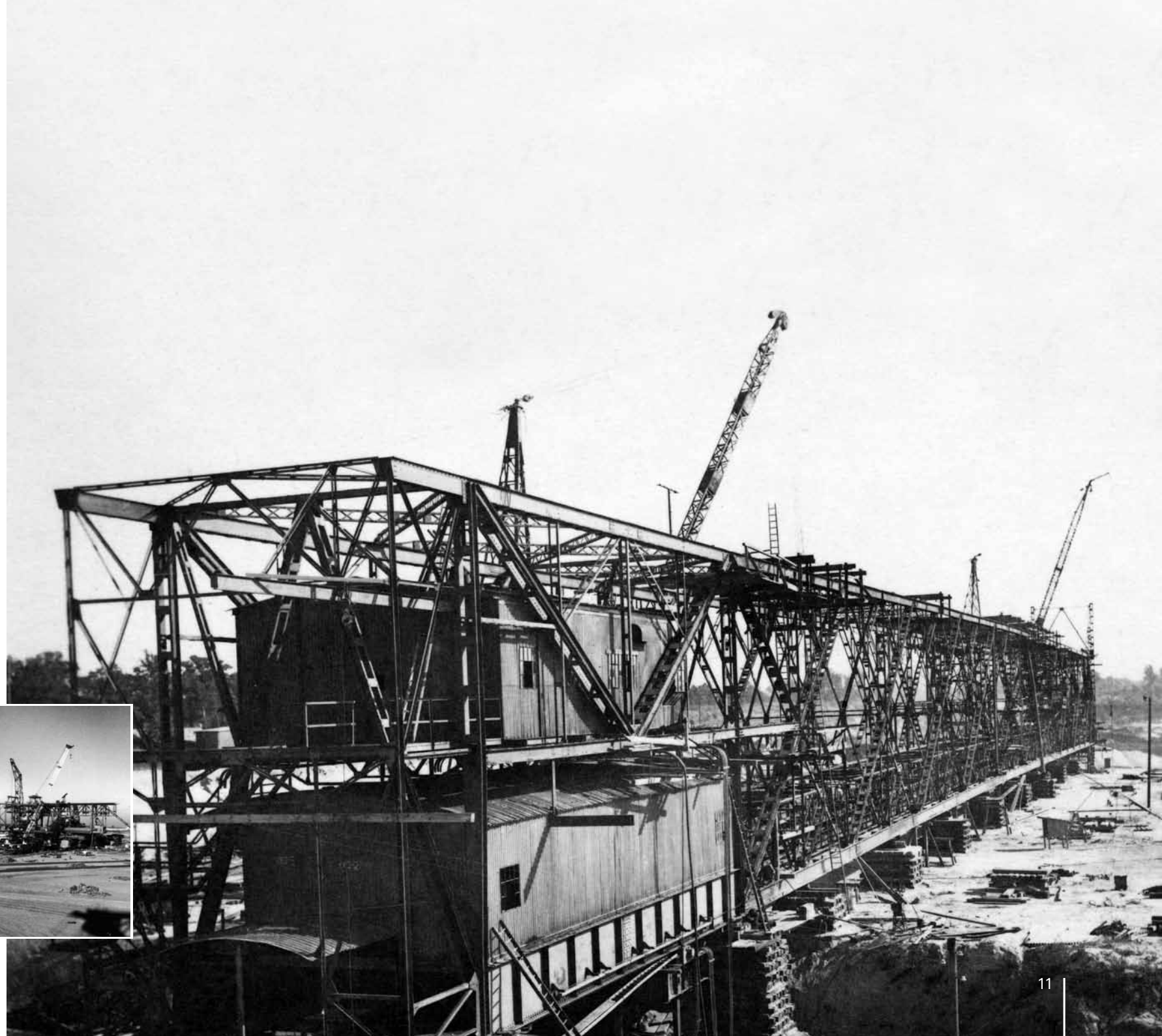
Montageplatz der Abraumförderbrücke Clara im Tagebau Werminghoff II, 1949
