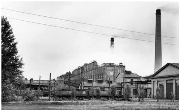
Schweißerei der Bahnwerkstatt der Grube Marga, um 1935 Zentralwerkstatt Ilse auf Anna-Mathilde, 1935
