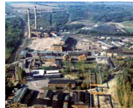
Brikettfabrik 69 und Hauptwerkstatt Lauchhammer-Süd (unten), 1994 Abbrucharbeiten und Materialtrennung am Veredlungsstandort Brieske, 1996
