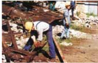
Abbrucharbeiten in der Werkstatt Erika/Laubusch, 1993
