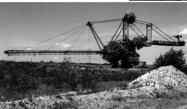
Sprengung des Absetzers 1077, 2000
