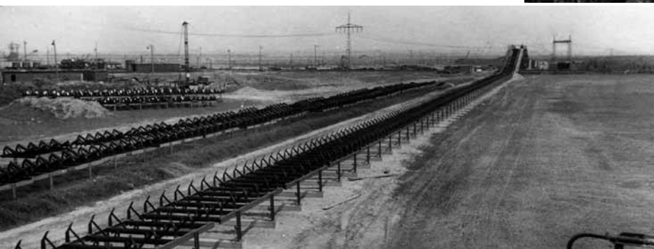
Aufbau der Bandanlagen im Tagebau Peres, 1965
