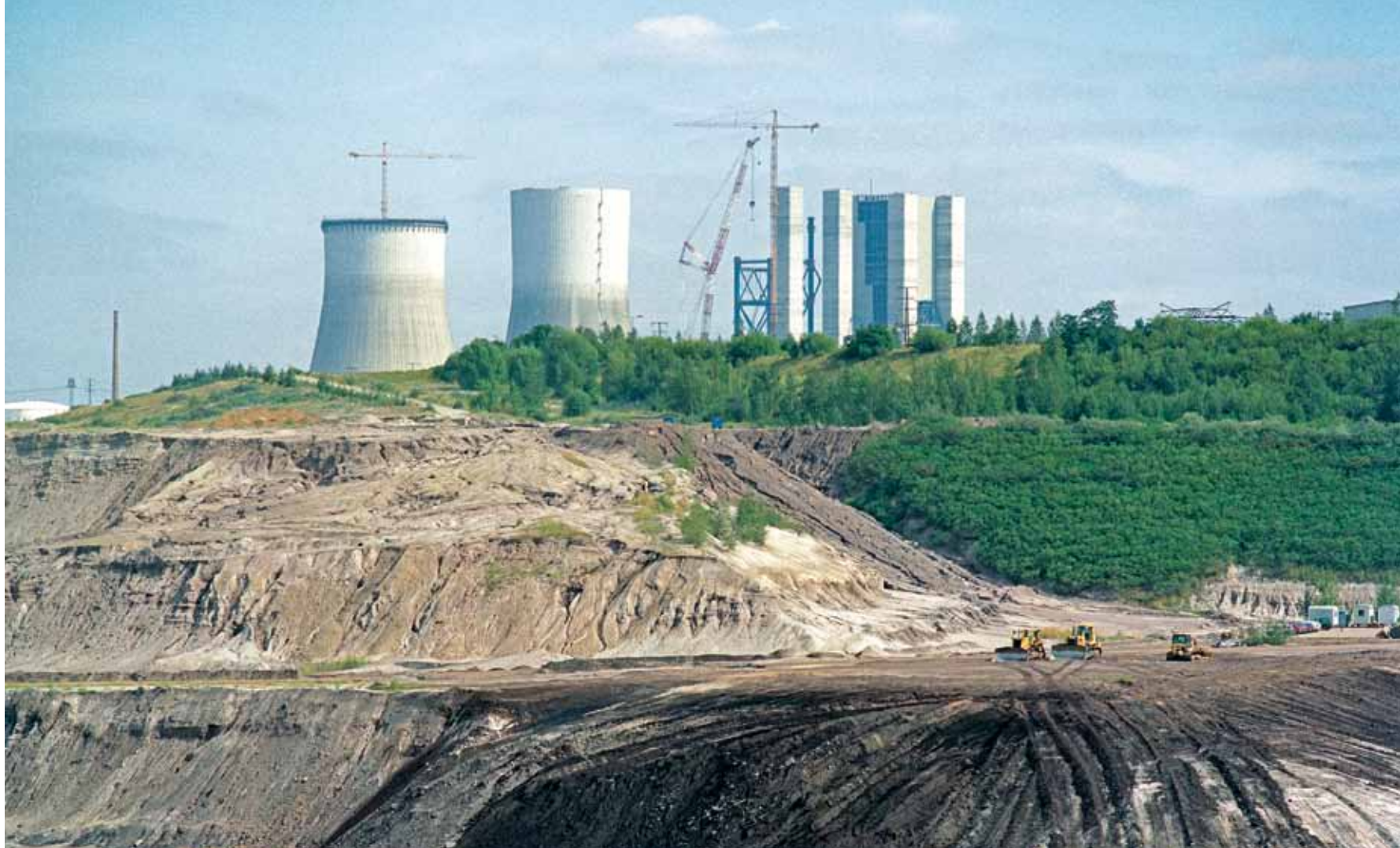
Sanierung der Böschungen im Dreiecksbereich der Gewinnung im stillgelegten Teil des Abbaufeldes Peres; im Hintergrund die Kraftwerksbaustelle Lippendorf, 1996
