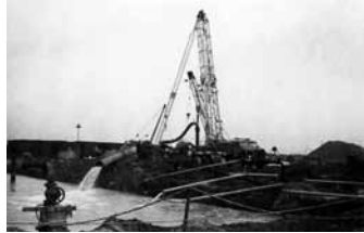
Abteufen des Schachtes 1 zur Entwässerung des Abbaufeldes Peres, 1964
