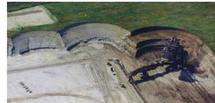
Kippenrückgewinnung im Baggerbetrieb auf der Kippe des Tagebaus Peres, 1997 Auftrag von Kulturboden auf die Böschungen und die ehemalige Baggerstrosse des ersten Abraumschnitts, 1992
