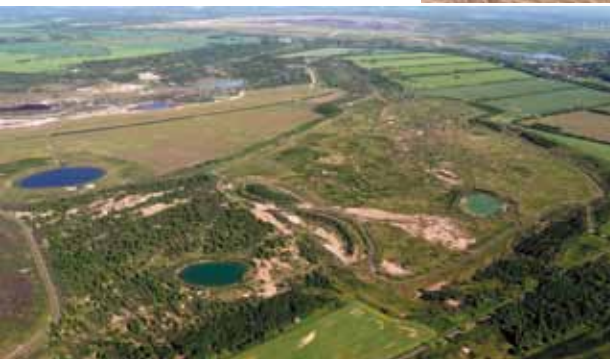
Verdunstungsbecken auf der Innenkippe Peres, 2011
