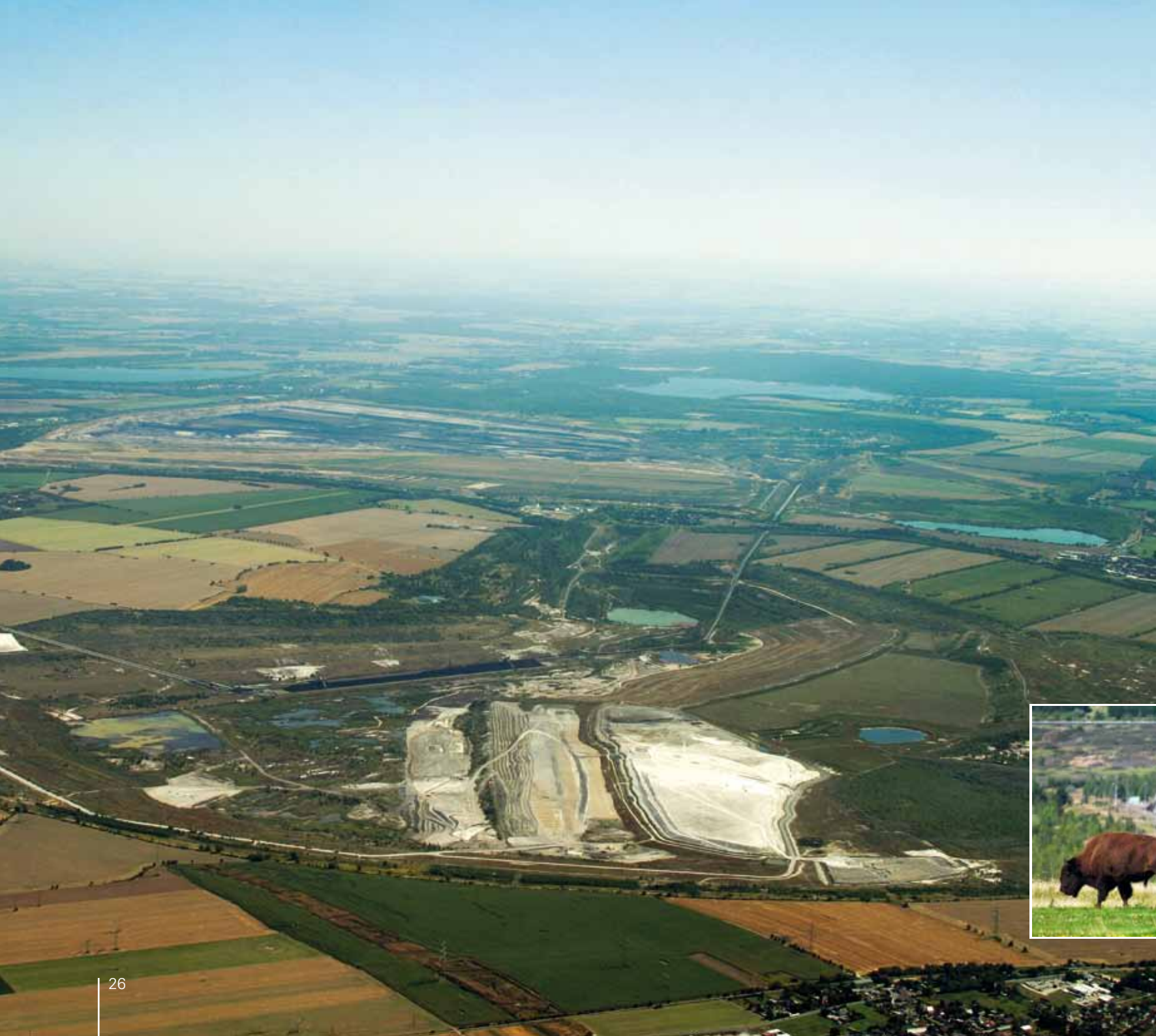
Liegendwasserhaltung des Tagebaus Vereinigtes Schleenhain im Abbaufeld Peres (links im Bild), 2009
