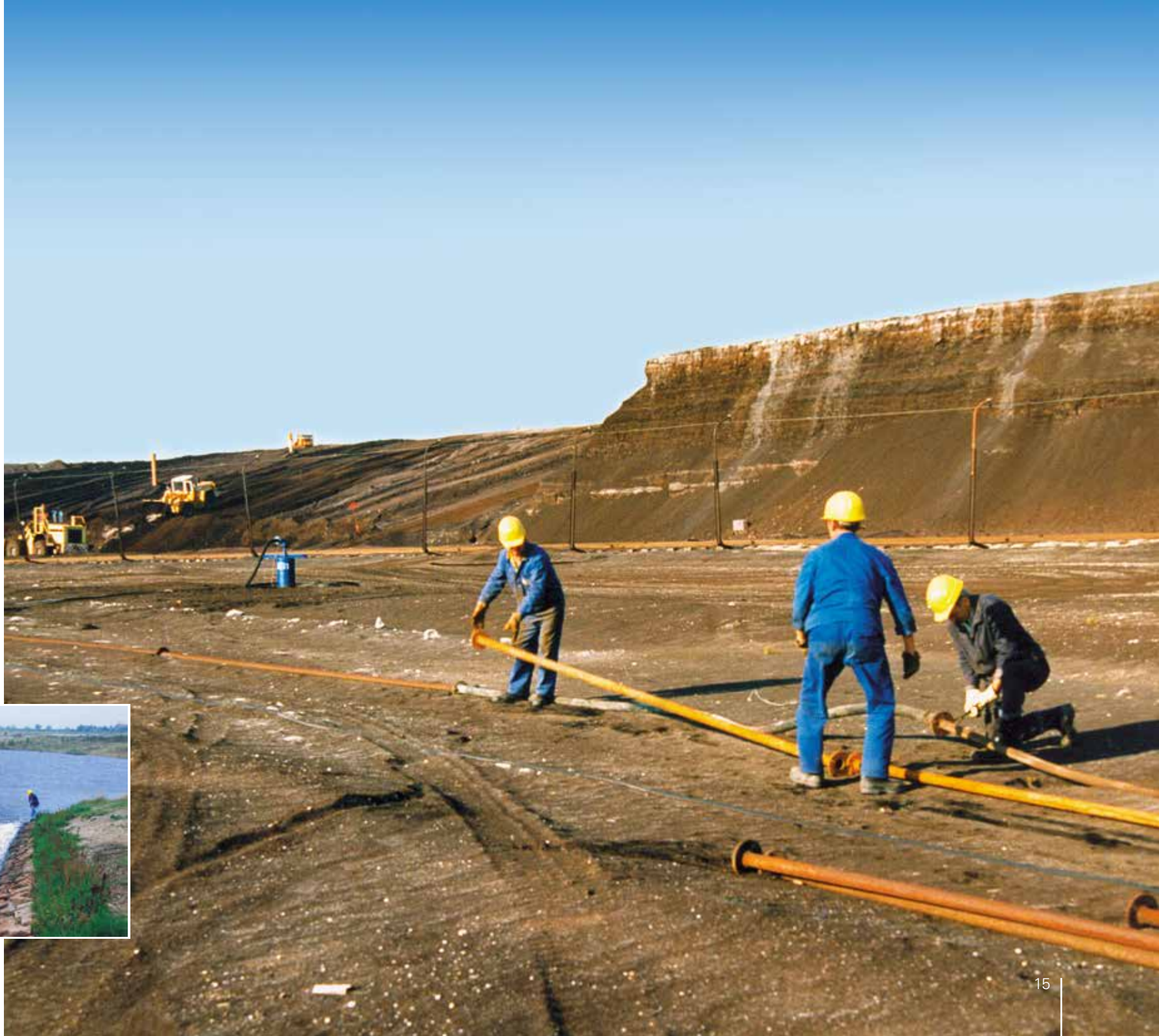
Böschungabflachung und Rückbau der Entwässerungsanlagen im Baufeld 1b des stillgelegten Tagebaus Merseburg-Ost, 1995
