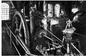
Zemag-Weiterentwicklung der Exter-Brikettpresse, Modell 1873 von Jacobi, in der Brikettfabrik Marie in Deuben, 1949
