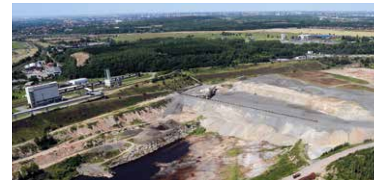
Ascheneinbau und Gipszwischenlagerung im Westschlauch der Deponie Lochau, 2009
