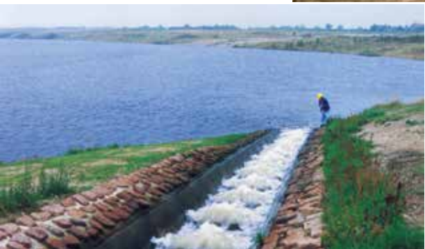
Flutung des Baufelds 1a im Tagebau Merseburg-Ost, 1998
