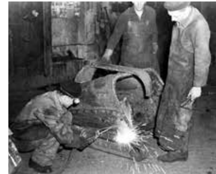
Schweißarbeiten zur Reparatur eines Eimers für einen Bagger im Tagebau Zwenkau, 1960 Instandhaltungsarbeiten an einem Getriebe, 1960
