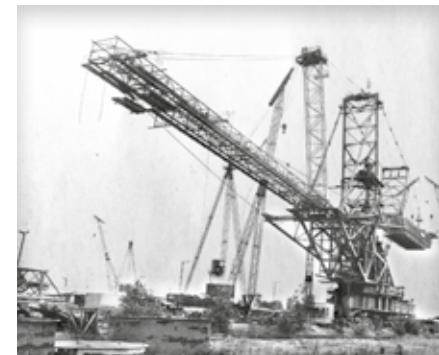
Absetzer A fs -B 10.000-1124 kurz vor der Endmontage auf dem Montageplatz „Käferhain“ im Tagebau Groitzscher Dreieck, 1984 Montageplatz für Bandanlagen im Groitzscher Dreieck, 1965
