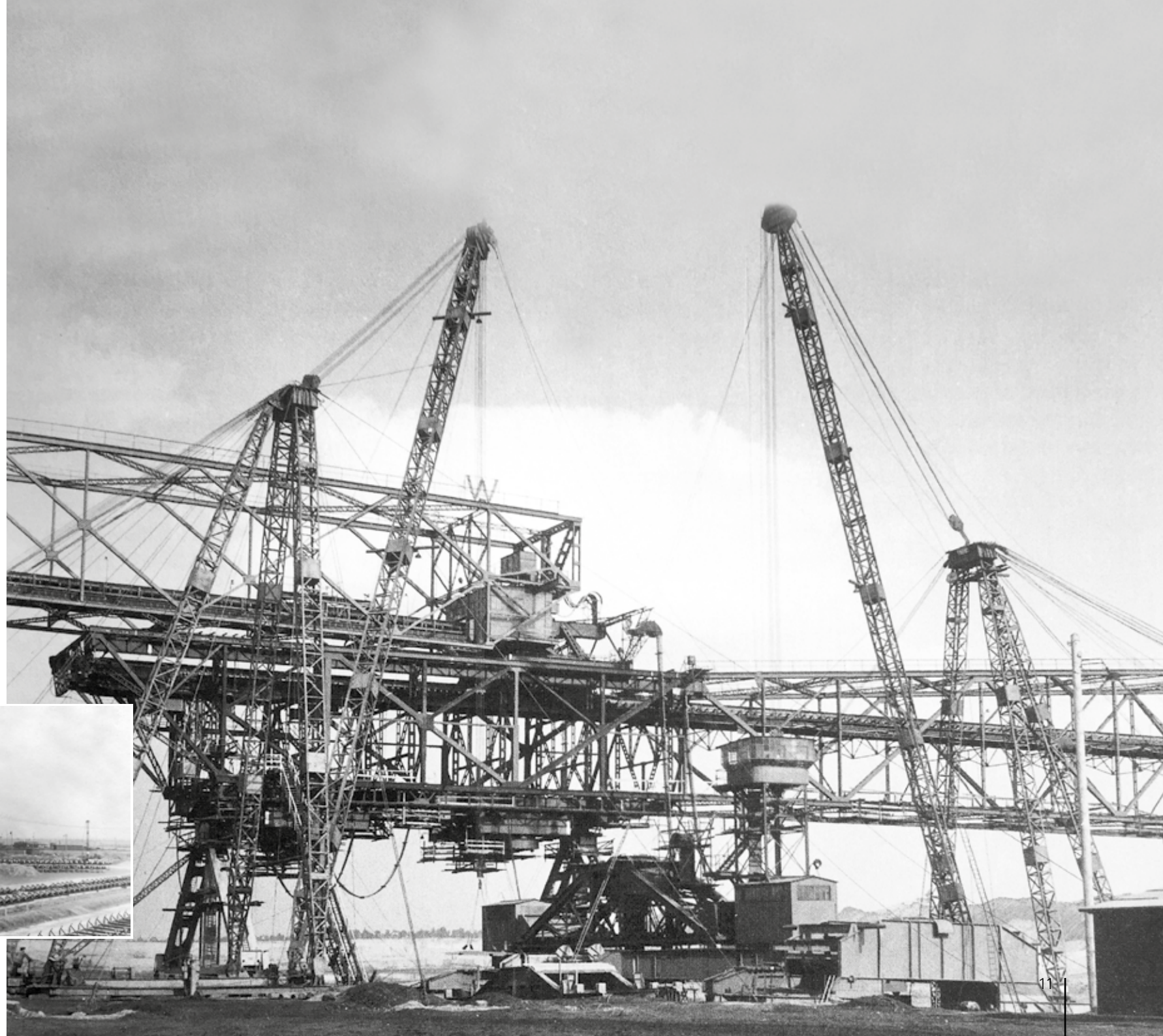
Umbau der Abraumförderbrücke AFB F45-18 für den Tagebau Böhlen, später Zwenkau, Verkürzung der Mittelstütze um drei Meter, 1962
